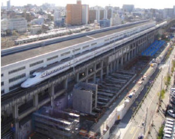
高架橋新設工事 (引上線部)
