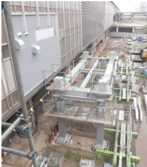
高架橋新設工事 (駅部)
