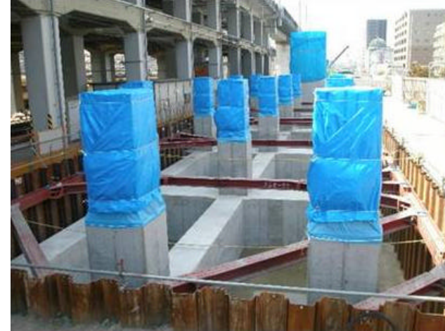
高架橋新設工事 (引上線部)
