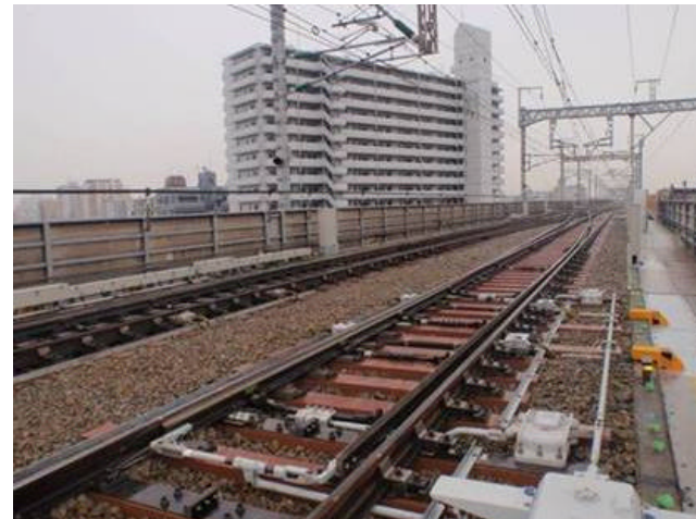
線路改良工事 (博多方)
