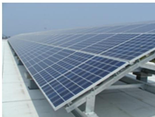
太陽光パネル
