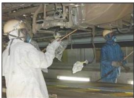
現在の床下気吹き作業
