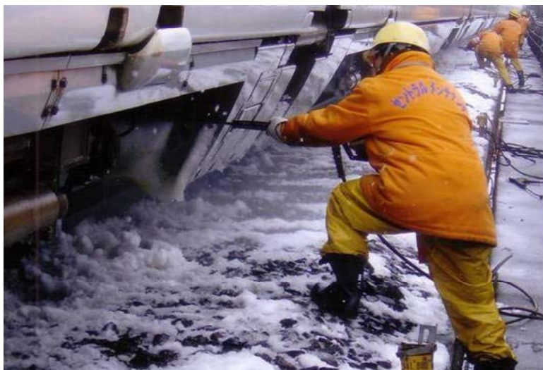
図5 高温高圧洗浄機を使用した雪落とし作業
