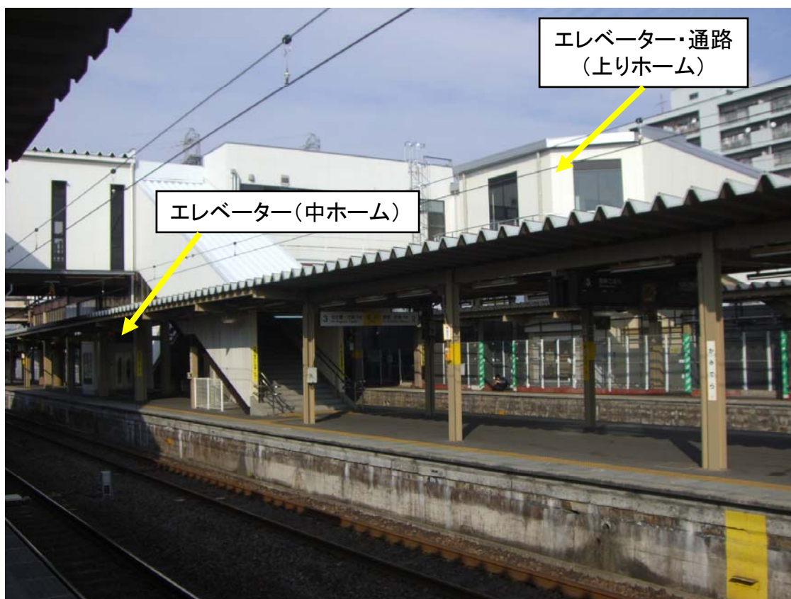
笠寺駅 障害者対応エレベーター・通路
