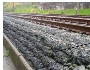
ジオテキバッグ製バラスト止め
