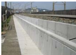
鉄筋コンクリート製バラスト止め
