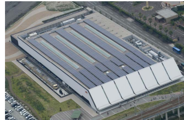
太陽光発電システム（リニア・鉄道館）
