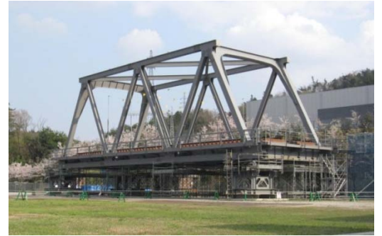
【試験トラス橋】
