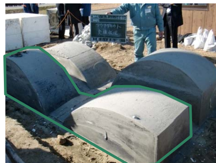
試験施工時の状況
