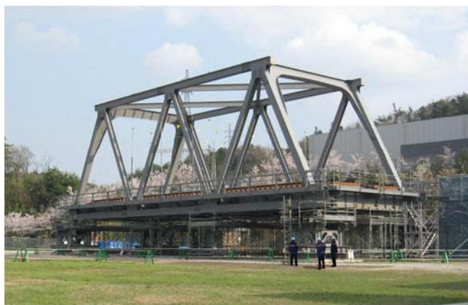
試験トラス橋
