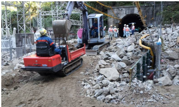
橋桁上の土砂撤去作業の様子 (H25. 9. 18)
