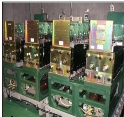
※走行中の新幹線が変電所の供給エリアをまたぐ際、高速のまま電源を瞬時に切替用開閉器により切り替えています。
