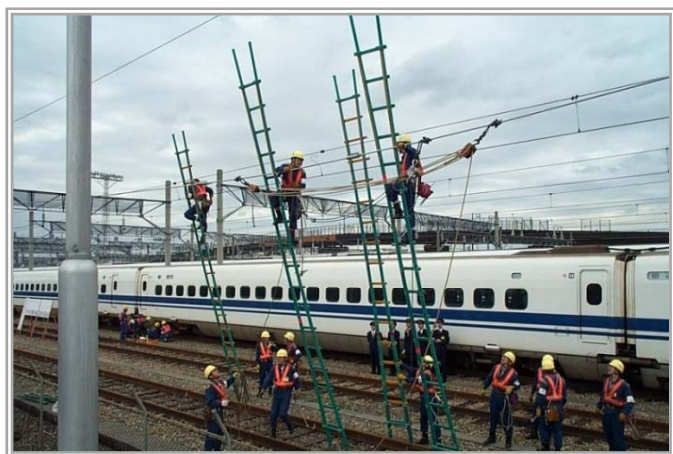
写真5 トリ線断線復旧訓練
