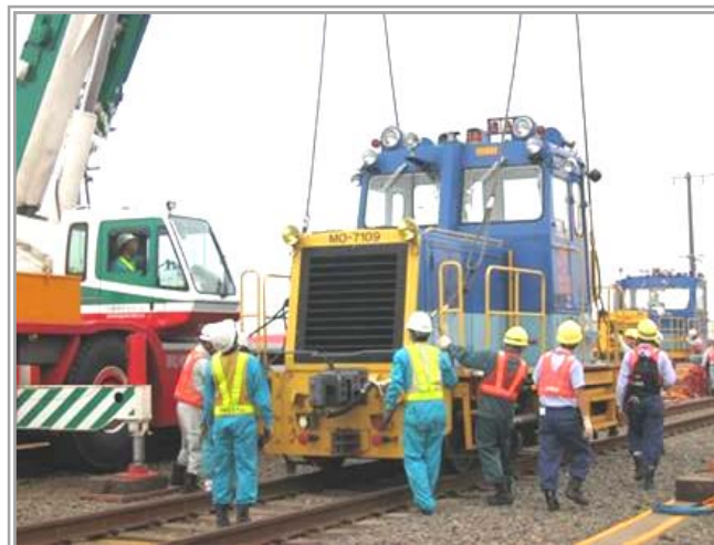
写真4 保守用車の脱線復旧訓練
