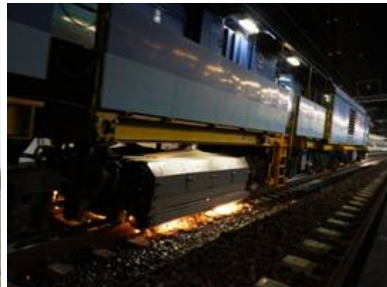
レール削正作業の様子
