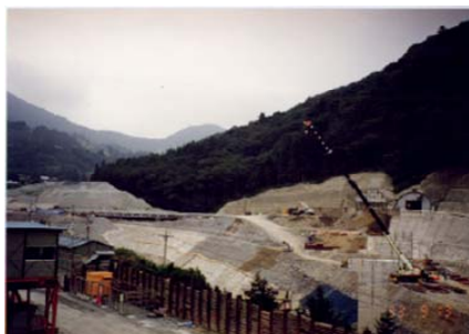
写真：山梨リニア実験線の発生土置き場の事例
