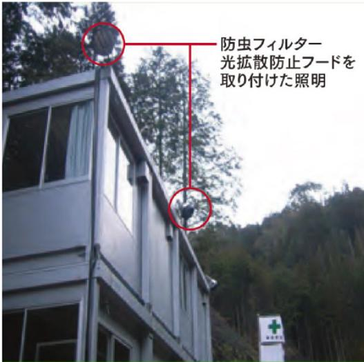
図 14-5-7 照明の漏れ出しの抑制の例
