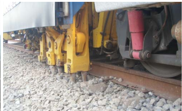
つき固め作業の様子
