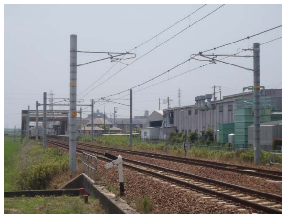
<石浜駅付近の電車線路設備の状況（設置完了）>
