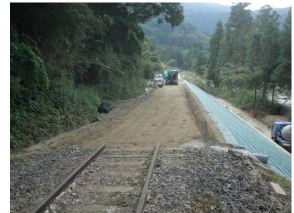
名松線復旧工事
