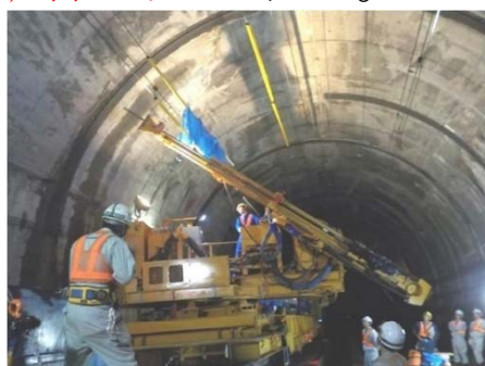
大規模改修工事（トンネル内ロックボルト施工）
