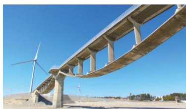
〔最寄駅〕掛川駅 潮騒橋
