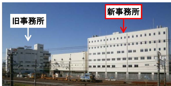
三島車両所事務所 外観
