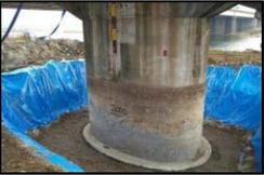
施工中<br>（大規模掘削） | 桁と橋脚に、地震による揺れを小さく抑える制震装置を複数設置し、地震エネルギーを吸収<br>堀川橋りょう（レンガ橋脚）<br>
