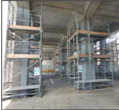
高架橋柱の耐震補強イメージ
