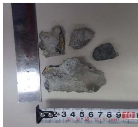
落下していたコンクリート片
