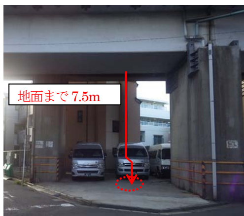
落下した場所 (丸点線が落下した範囲)
