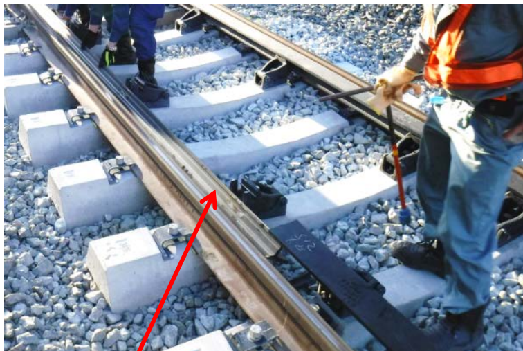
外れていた 脱線防止ガード
