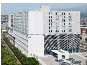
総合研修センター(外観)
