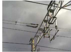
仮設鋼材垂下 1箇所
