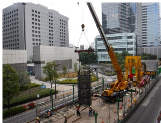
品川駅：地中連続壁の構築
