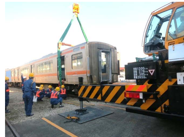
車両の脱線復旧訓練
