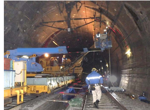
大規模改修工事
