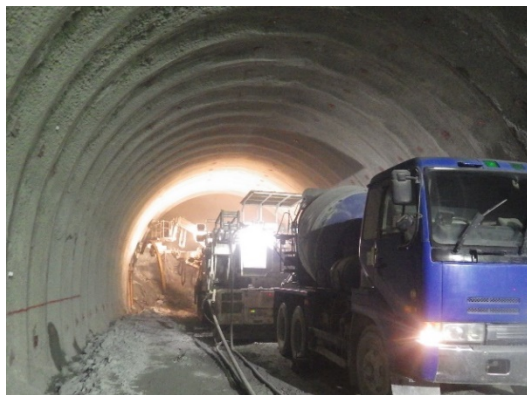
南アルプストンネル(長野工区)：斜坑の掘削
