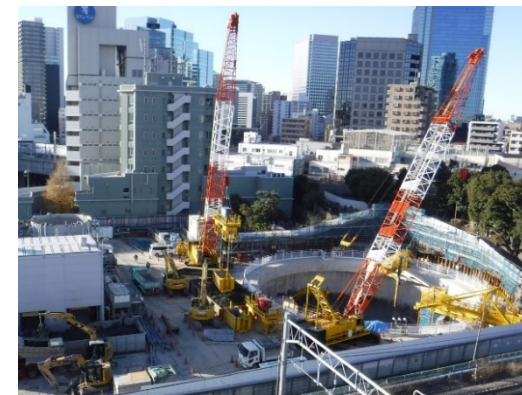
北品川非常口：立坑の掘削
