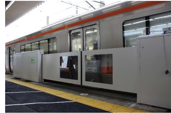
金山駅で実証試験中の可動柵
