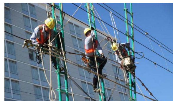
梯子を使用し、切れたトロッコ線を繋ぎ直す訓練
