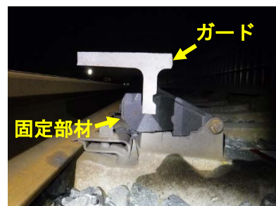
「新仕様の固定部材」設置状況
