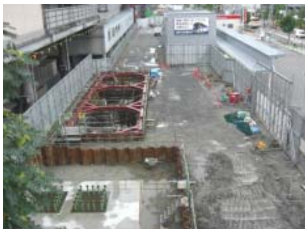
高架橋基礎工事(駅部)
