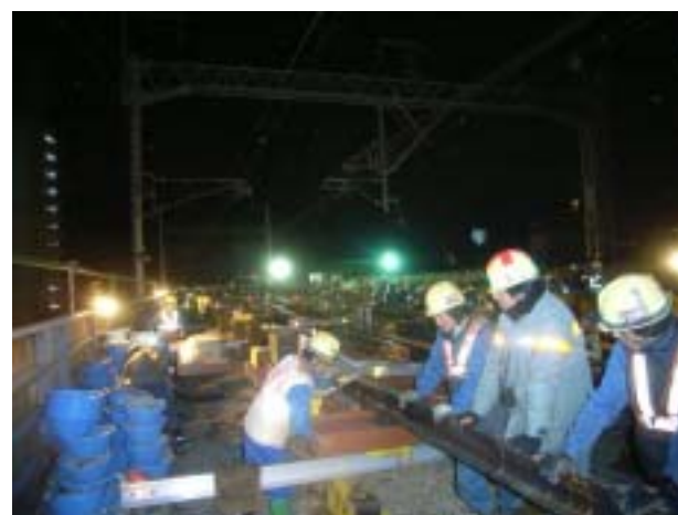
線路改良工事(博多方)
