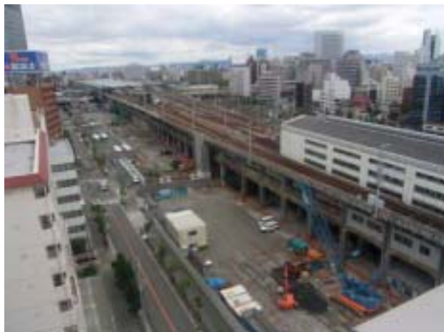
高架橋基礎工事(引上線部)
