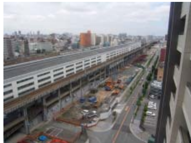
高架橋基礎工事(引上線部)
