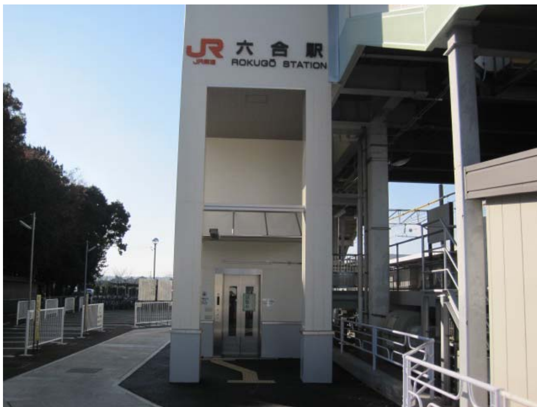
エレベーター・南口(下り線)
