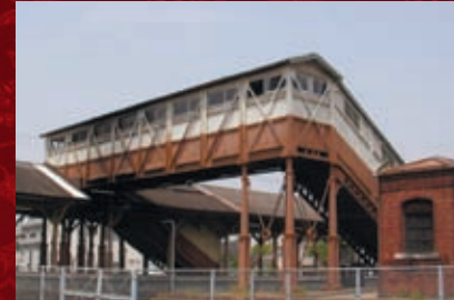
半田駅跨線橋
