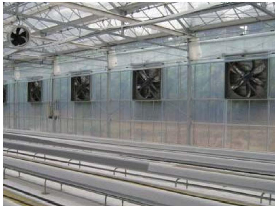
パッド&ファン冷房システム(大型ファン設置側)
