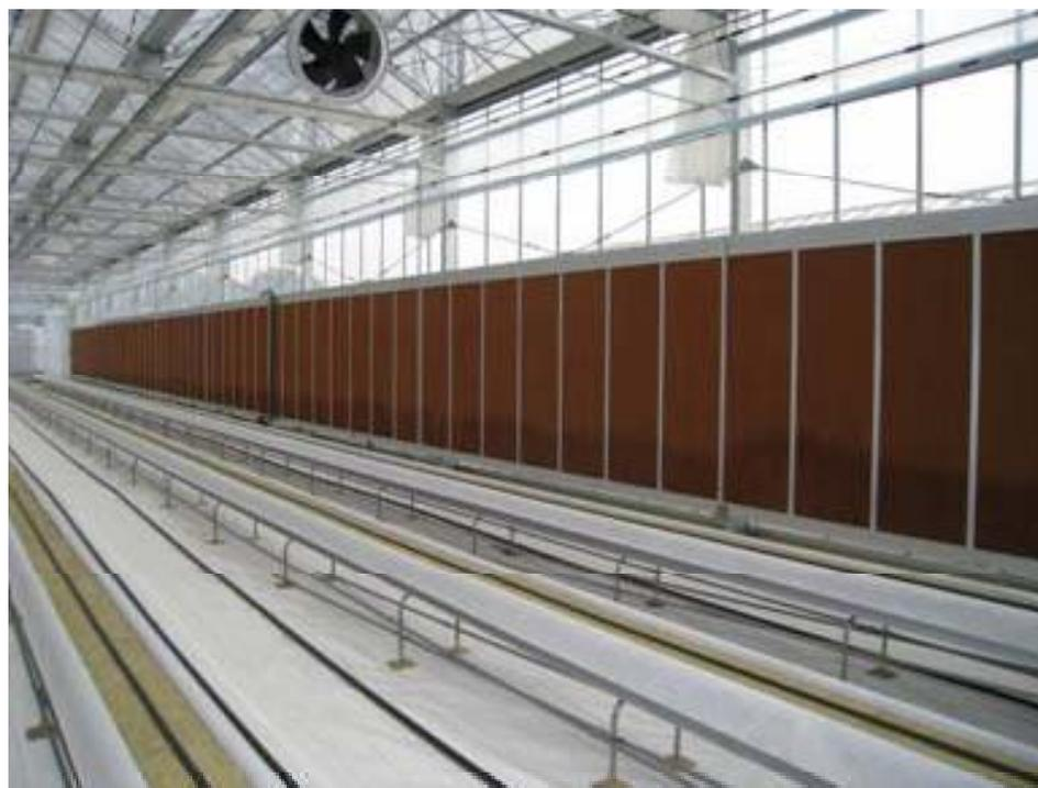
パッド&ファン冷房システム(流水パッド設置側)
