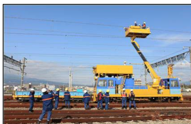
写真6 電力保守用車を使用した 設備点検訓練
