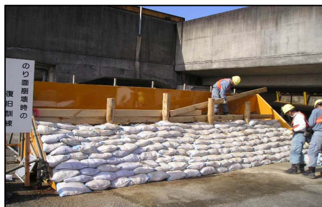
写真2 のり面崩壊時の復旧訓練
