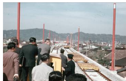
建設中のモデル線（提供：星晃）
