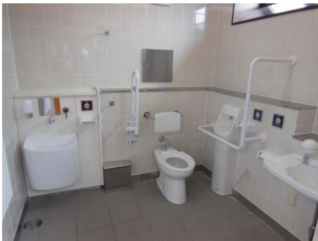
函南駅 多機能トイレ
