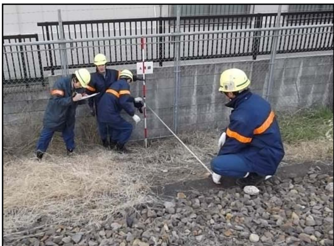
写真1 崩壊したのり面の 応急復旧訓練
