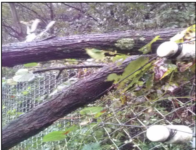
写真3 倒木撤去及び 落石検知線復旧訓練
