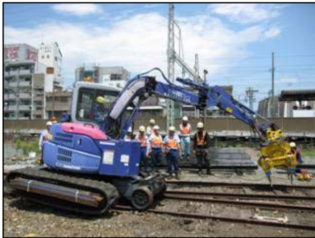
写真2 バックホータイトパを活用した 碎石流出復旧訓練
