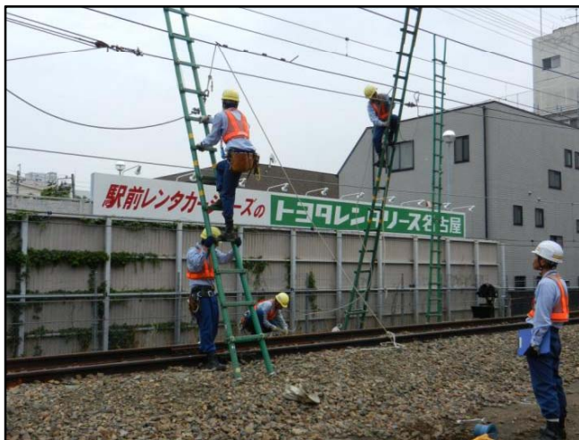
写真4 ちょう架線断線復旧訓練
