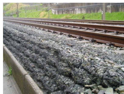
通常のジオテキバッグ敷設工事の様子
