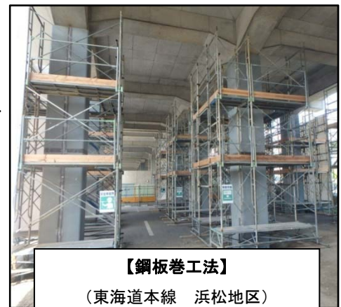
耐震補強工事の状況
