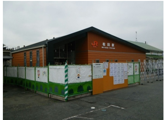
【新駅舎への建替】（御殿場線 松田駅）
