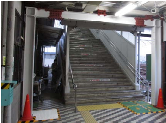
【鉄骨フレームによる補強】（東海道本線 清洲駅）
