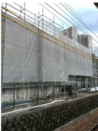
作業現場の外観
