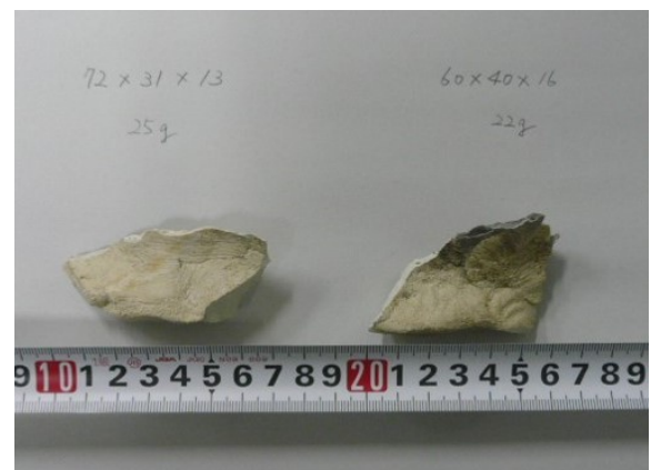
落下したコーキング材
