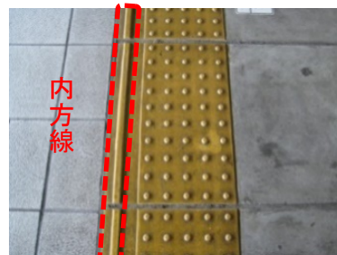
内方線付き点状ブロック
