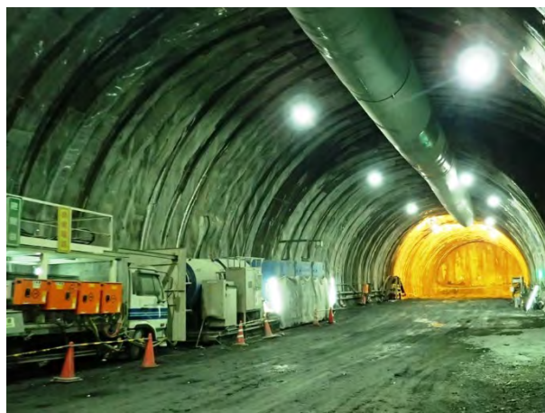
南アルプストンネル(山梨工区)：本線トンネルの掘削
