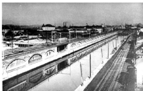
【完成当初の煉瓦アーチ高架橋】
