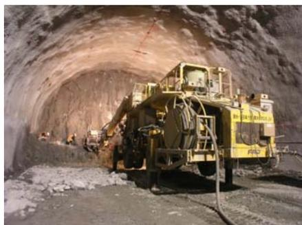
日吉トンネル（南垣外工区）：本線トンネルの掘削
