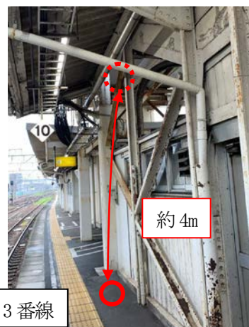
3番線 落下箇所(沼津駅上りホーム)
