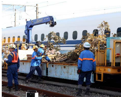
飛来物除去に用いるクレーン
