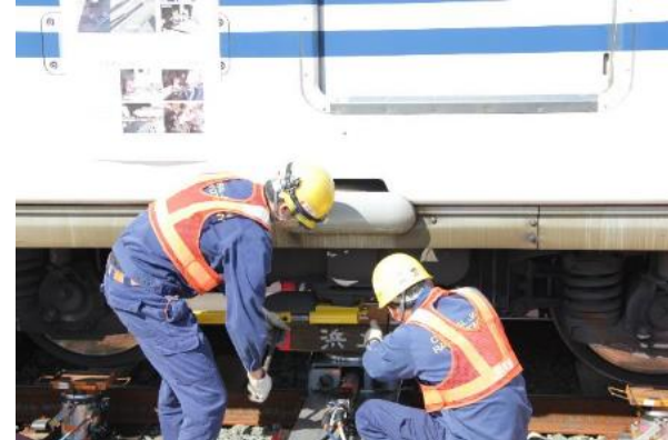
復旧機材の装着
