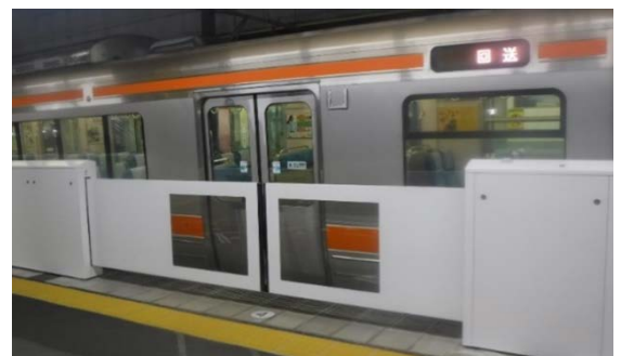
東海道本線金山駅ホーム可動柵（3番線）
