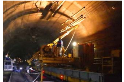
大規模改修工事
