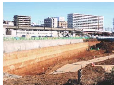
神奈川県駅(仮称)：駅構造物構築に向けた掘削
