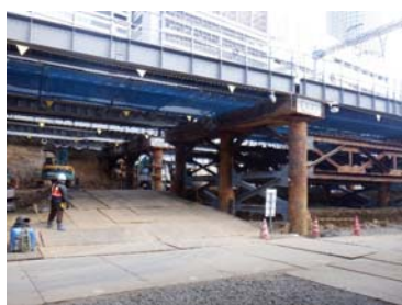
名古屋駅：在来線の線路下掘削
