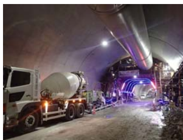
日吉トンネル(南垣外)：本線トンネルの覆工
