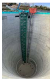
坂下非常口：躯体の完成
