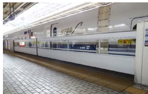
新大阪駅 大開口可動柵
