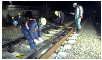
脱線防止ガード敷設
