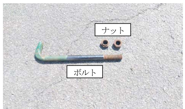
落下したボルト及びナット
