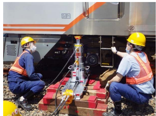
HC85系を用いた脱線復旧訓練
