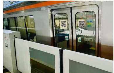
QRコードを利用した可動柵開閉システム
