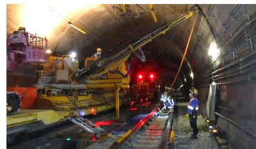
大規模改修工事
