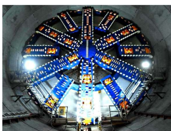
第一首都圏トンネル（北品川工区） 掘進に向け設置されたシールドマシン
